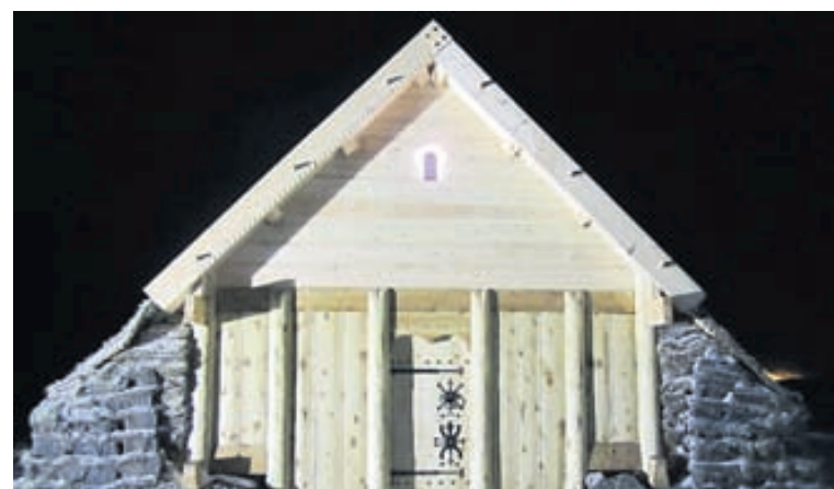
LÚÓS Í GLUGGA Þorlákshúsið er nær tilbúið að utan. Framhliðin er klár og á Þorlákshúsi, dánardægri Þorlákshelga, var kveikt á ljósi í kvistglugga búðarinnar.
