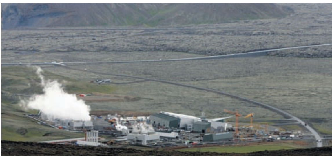
HELLISHEIÐARVIRKJUN Hverahlíðarvirkjun verður á Hellisheiði, skammt suðaustur af Hellisheiðarvirkjun, hægra megin við þjóðveginn, komi fólk akandi frá Reykjavík.
