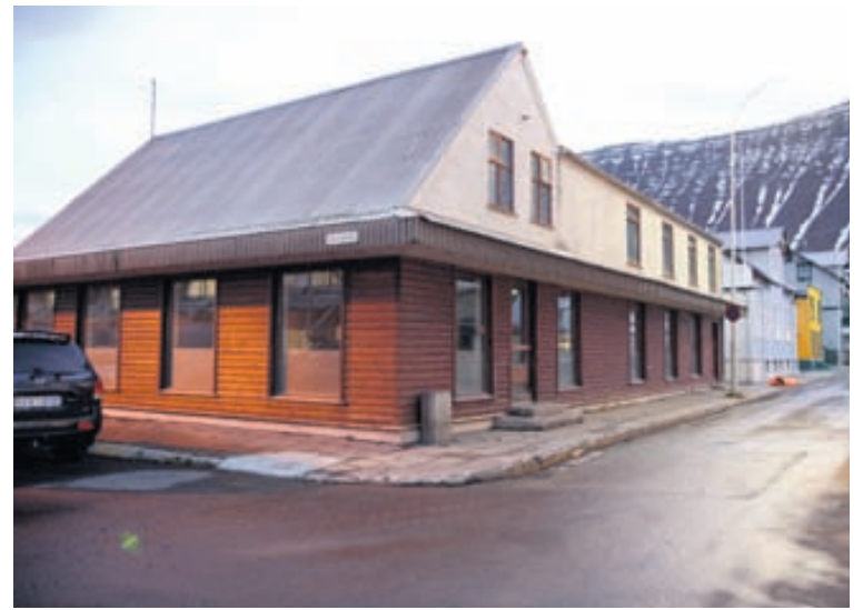
SILFURGATA 5 Nú stendur til að opna gistihús í Norska bakaríinu á Ísafirði og komu munirnir í ljós þegar veggir á efri hæð hússins voru brotnir niður.
