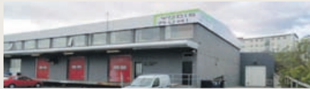
Vatnagarðar 6 - 104 Rvk. 1200 m 2 þjónustu- og lagerhúsnæði
