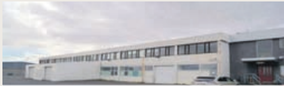
Vatnagarðar 8 - 104 Rvk. 2200 m 2 þjónustu- og lagerhúsnæði
