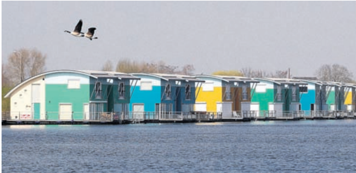
FLOTHÝSI VIÐ ÁNA MEUSE Í HOLLANDI Þessi íbúðarhús standa á landi en fara á flot þegar vatn flæðir undir þau. Húsin voru reist árið 2005 og stóðust allar væntingar í flóðunum miklu á síðasta ári.
