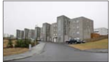
Andrésbrunnur - 4herb jarðhæð. Góð vönduð 111 fm íbúð á jarðhæð. 3 góð svefnherbergi og stæði í bílskylí. Afgirtur sólpallur í sérgarði. Vandaðar innréttingar og gólfefni. V. 27,9 m.
