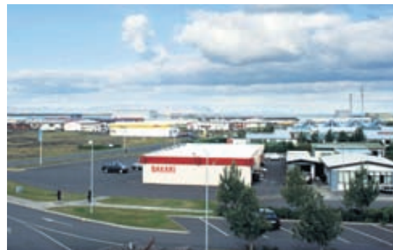
ÞORLÁKSHÖFN Sjöundubekkingar gengu um Þorlákshöfn á umhverfisdegi og komust að því að reykt er of nærri inn-göngum ýmissa opinberra bygginga.
