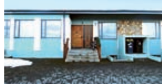
Torfufell – Raðhús Með 3 leigubúðum og bílskúr Fallegt 128 fm raðhús sem er á einni hæð með 24 fm bílskúr og 3 leigubúðum í kjallara sem að gefa góða tekjurmöguleika. Húsið er mikið endurnýjað. Nýtt eldhús. Nýtt bað. Kjallari undir öllu húsinu þar er búð að innrétta 3 litlar íbúðir. Verð 43,5 millj.
