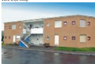
Starengi – 3ja herb. Falleg 3ja herbergja íbúð á 1. hæð (jarðhæð) í snyrtilegu nýlegu 2ja hæða fjölbýli. Fallegar innréttingar. Parket og flisar. Gengið úr stofu út á afgirta séríð með verönd í suður. Sérinngangur. Þvottahús í íbúð. Stutt í alla þjónustu. Góð eign fyrir dýravini. Verð 21,0 millj.
