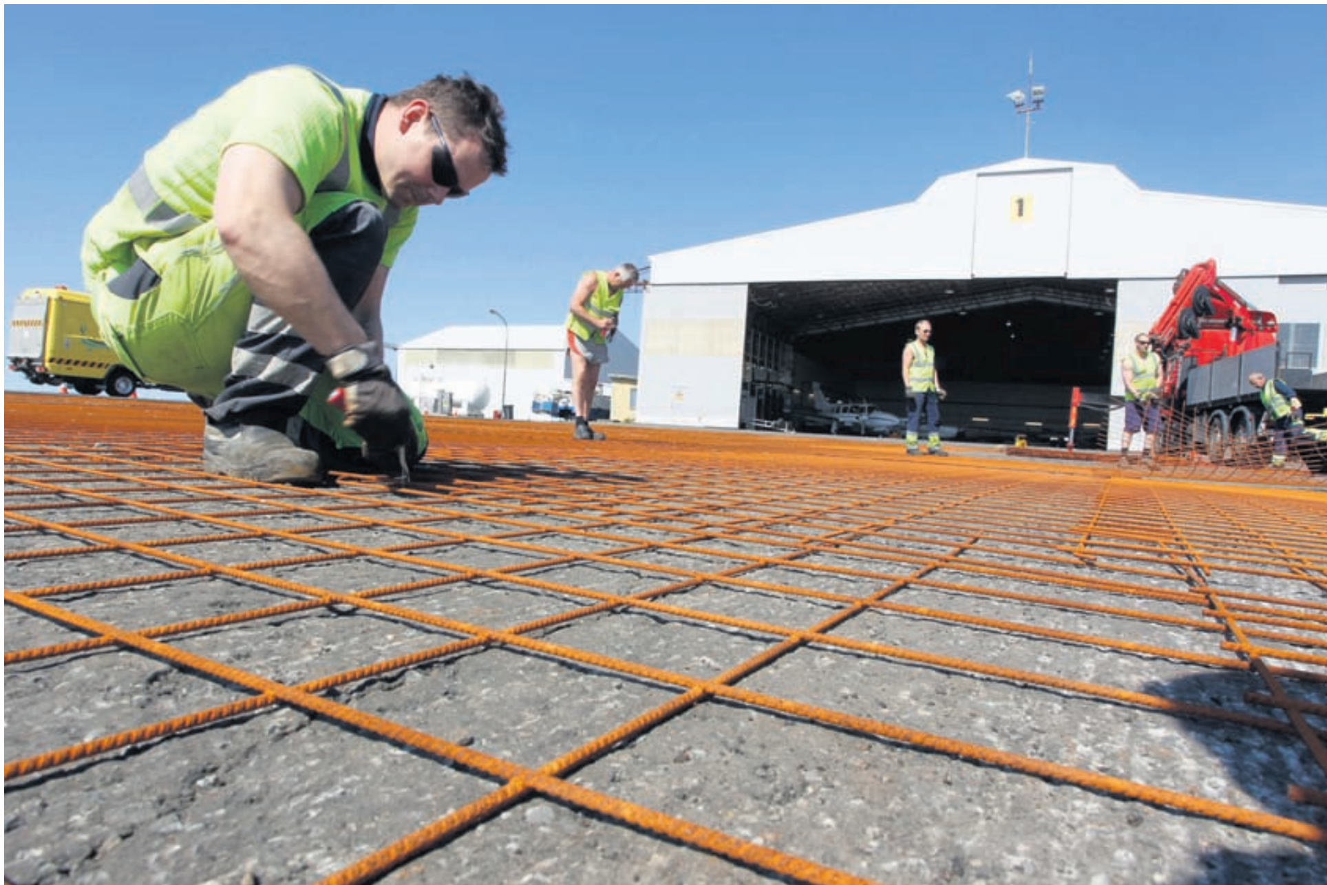
Unnið að viðgerð á Reykjavíkflugvelli. Járnet er lagt undir malbikið til að auka burðarþol.
