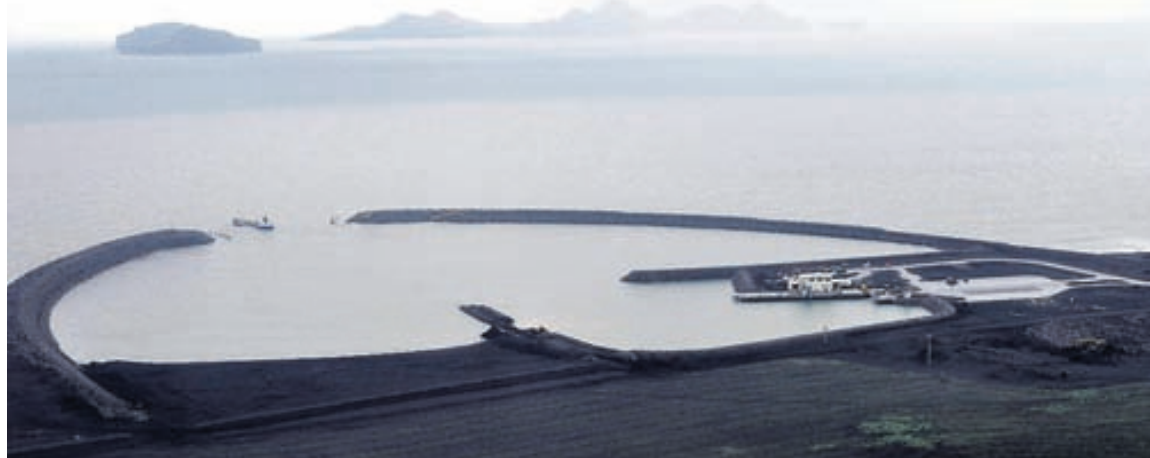
LANDEYJAHÖFN Alls fara 1,8 milljarðar króna í framkvæmdir við Landeyjahöfn á fjögurra ára samgönguáætlun. MYND/ÓSKAR P. FRÍÐRIKSSON
