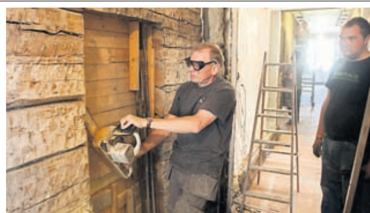
ENGIN VETTLINGATÖK Hér er Gunnar Bjarnason trésmiður við vinnu sína. Norskir viðir hússins eru í góðu ástandi þó gamlir séu. FRÉTTABLAÐIÐ/ANTON
