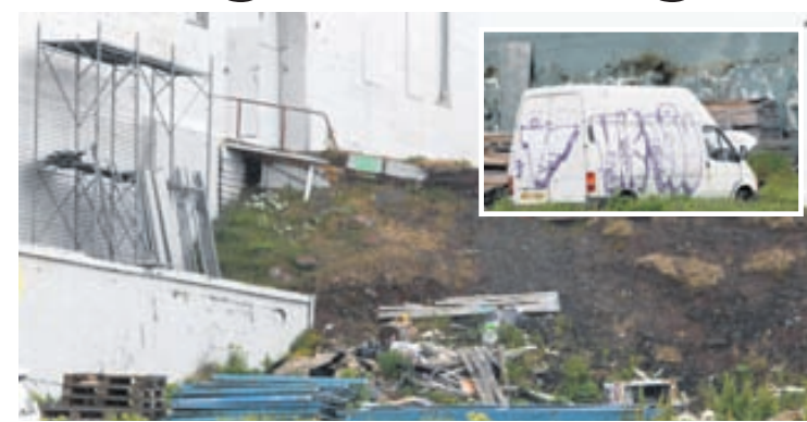
GAMLA HÉDINSÞÓR Borgarbúi sendi Fréttablaðinu ábendingu um sóðaskap á lóðinni. Hann telur líklegt að fólk hendi rusli á lóðina í stað þess að fara með það í Sorpu, sem er skammt frá. FRÉTTABLAÐIÐ/ÞJETUR
