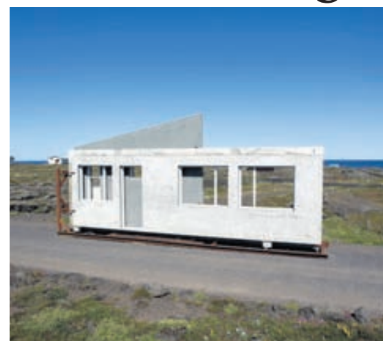
SÉÐ FRÁ REYKJANESBRAUT Húseiningarnar blasa við frá Reykjanesbrautinni og líkjast helst listaverki sem hefur verið komið þarna fyrir.
