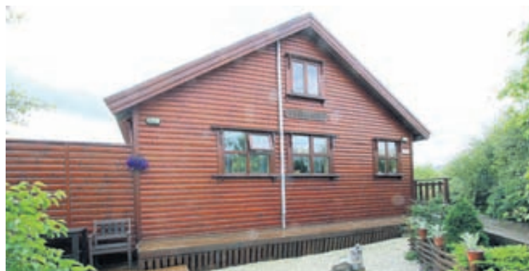
Fallegt sumarhús í Reykjaskógi.
