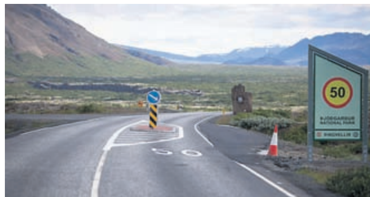
ÞÉTTBÝLISHLIÐ Vegagerðin hefur komið fyrir þéttbýlishliðum við enda þjóðgarðsins, enda 50 kílómetra hámarks hraði á veginum eins og í þéttbýli.
