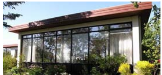
Fallegt og vel staðsett 285 fm einbýlishús. Á hæðinni er forstofa, snyrting, hol, stofur, eldhús með borðkrók, þvottaherbergi, gangur, fjögur herbergi og baðherbergi. Á neðri hæðinni er innbyggður bílskúr, óskráð geymsla og ósamþykkt tveggja herbergja íbúð sem er með sér inngangi en einnig er innangengt í íbúðina milli hæða. V. 69,9 m. 1842
