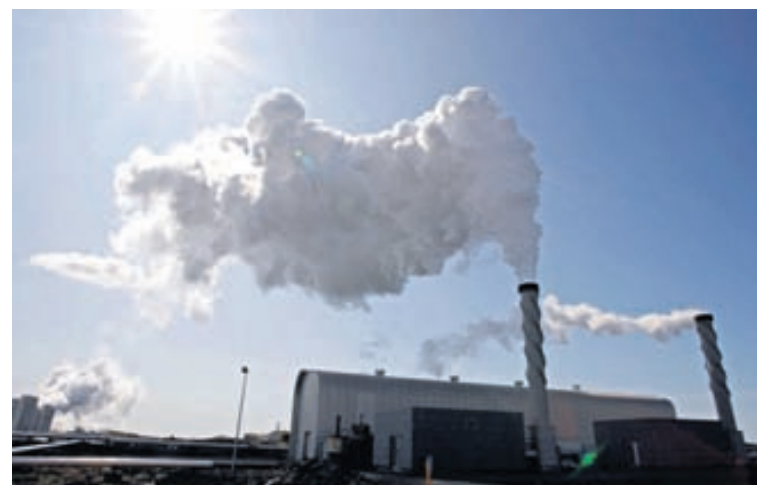
SVARTSENGI CRI rekur verksmiðju í Svartsengi þar sem endurnýjanlegt metanól er framleitt en verksmiðjan nýtir koltvísýring sem losaður er frá jarðvarmavirkjun HS Orku á svæðinu.
