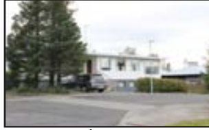
GILSÁRSTEEKKUR 109 Rvk. Einbýli. stórar þaksvalir, aukaíbúð, góð staðsetning í lokaðri götu.
