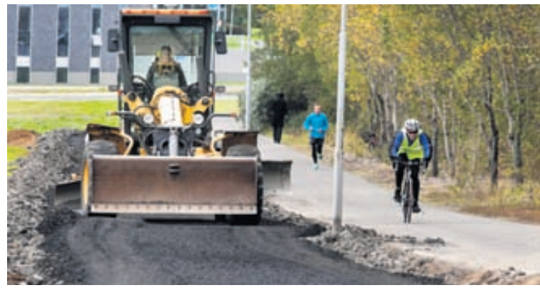
VIÐ SUÐURLANDSBRAUT Framkvæmdir standa nú yfir við göngustíg við Suðurlandsbraut. Breikka á stíginn til að betur megi aðskilja gangandi og hjólandi umferð. FRÉTTABLAÐIÐ/ANTON
