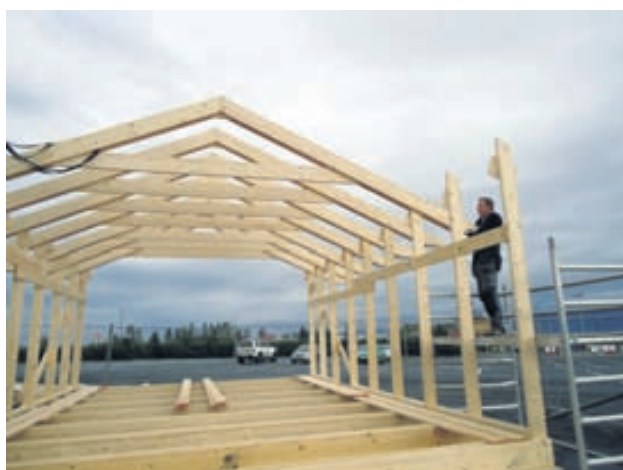
Burðarviður í húsin kemur tilsniðinn í réttum stærðum og lengdum ásamt festingum með greinargóðum leiðbeiningum.
