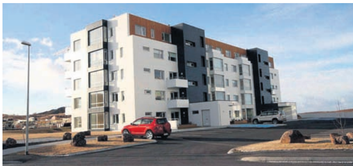
Húsið stendur við Boðarþing og eru 34 íbúðir í því, 2ja og 3ja herbergja.
