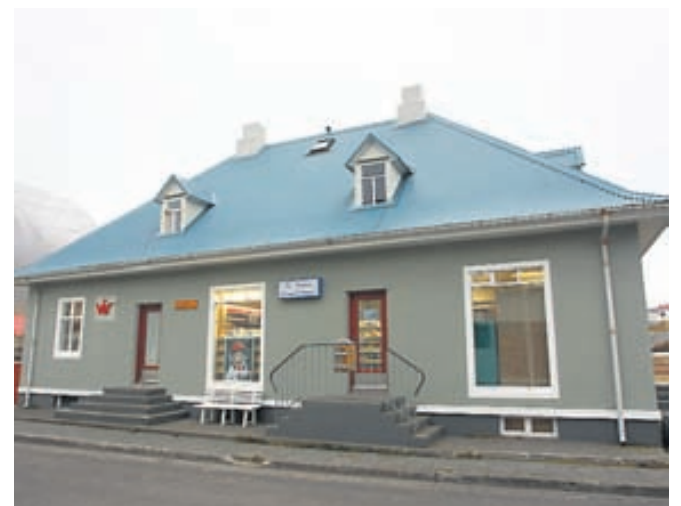
BYGGT 1917 Verslun Bjarna hefur verið í húsinu frá 1927, kaupmannsfjöl-skyldan bjó uppi.
