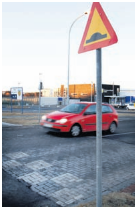
SAFAMÝRI Gönguleið yfir Safamýri liggur eftir hraðahindrun þar sem gatan hefur verið þrengd. Þarna er engin gangbraut svo bílarnir eiga réttinn, en þessi hönnun þykir bjóða upp á rugling.
