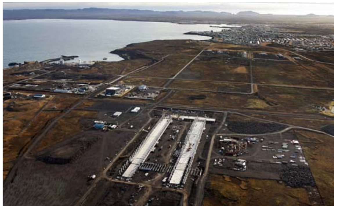
HELGUVÍK Framkvæmdir við álverið í Helguvík eru hafnar fyrir nokkru, eins og þessi mynd frá 2009 ber með sér. Ýmislegt þarf þó að ganga upp áður en ál verður framleitt í þessum húsum.
