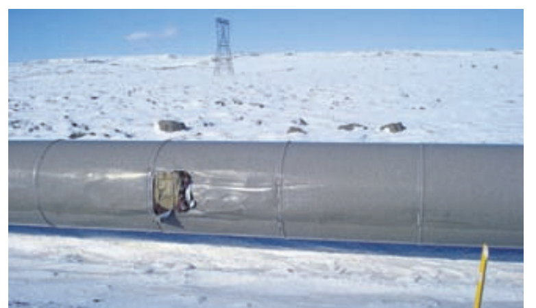
KLESST Á Einhver hefur ekið utan í Nesjavallalögn OR með þeim afleiðingum að hlífðarkápa rifnaði. MYND/OR
