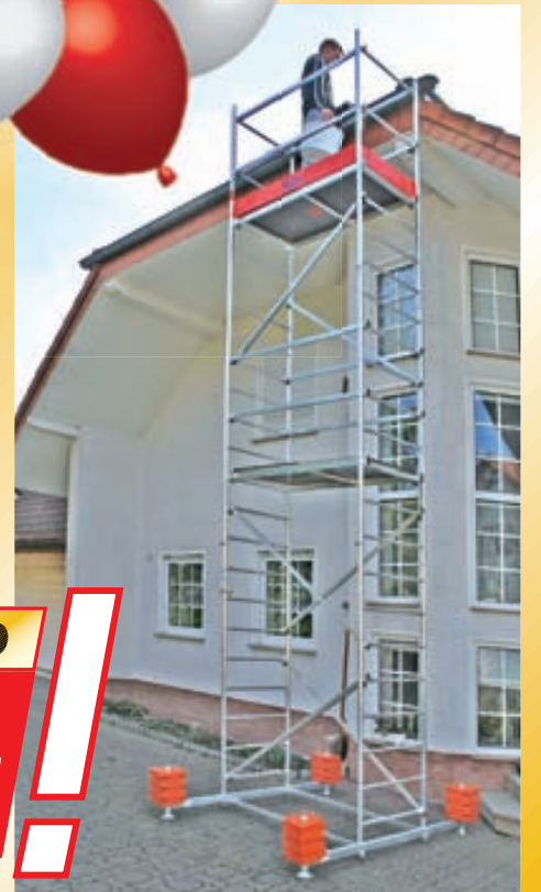
FÆRANLEGUR VINNUPALLUR Fullbúinn vinnupallur sem má skipta í hluta og nota í þrenns konar hæð, 1,95, 4 og 6 m. Háms. vinnuhæð u.þ.b. 7 m. Hjól, lóð og stuðningsfætur fylgja ekki.
