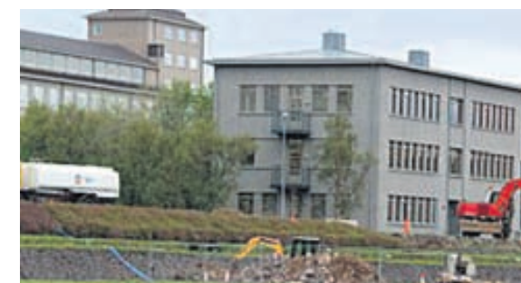
UNNIÐ AÐ VERKINU Framkvæmdir standa yfir neðan við Aðalbyggingu HÍ.
