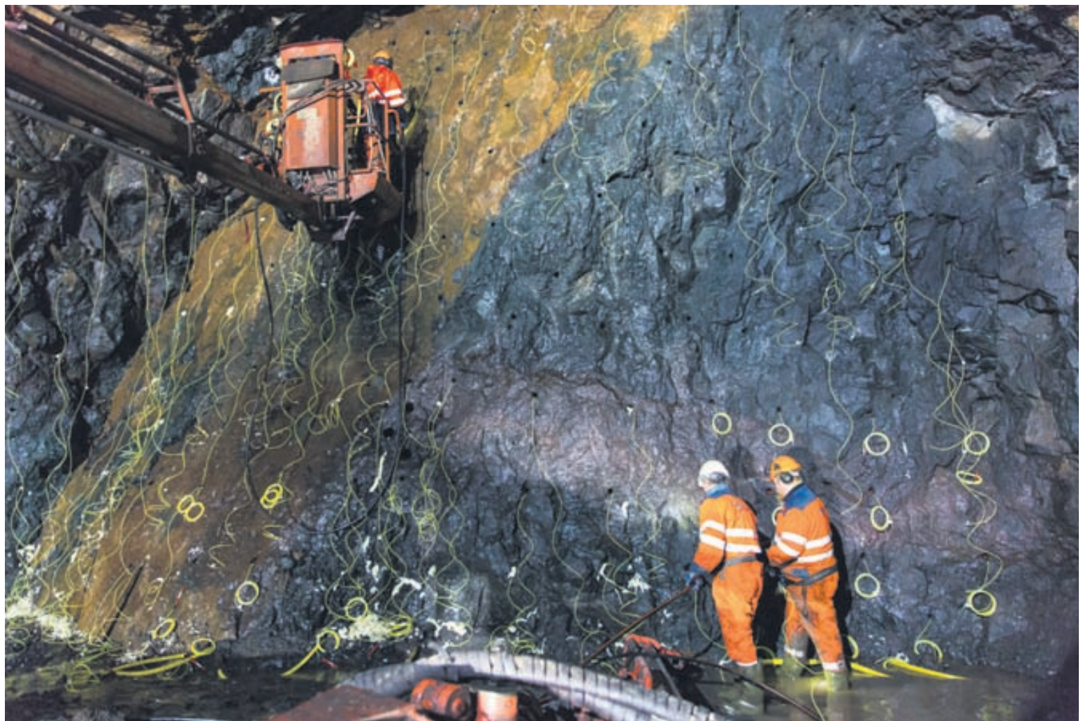
KOMA FYRIR SPRENGIHLEÐSLUM Vaðlaheiðargöng eru orðin 500 metra löng. Göngin hafa lengst um 60 metra á viku frá því sprengingar hófust í byrjun júlí. Á myndinni sjást starfsmenn Ásafis hlaða 700 kílógrömmum af sprengiefni í holur í berginu. Stefnt er að gegnumbroti í september 2015. Sjá síðu 10 MYND/AUDUNN NIELSSON
