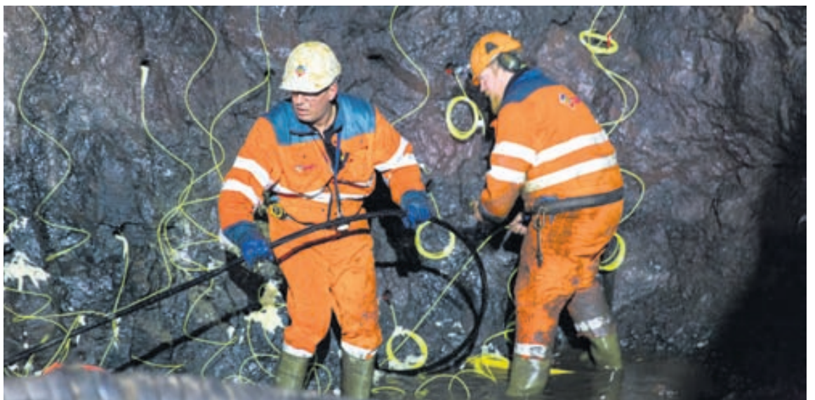
ÖFLUGT SPRENGIEFNI Starfsmenn Ósafis hlaða sprengiefni í holur í berginu. Oftast er sprengt tvisvar á sólarhring og hver sprenging lengir göngin um fimm metra að meðaltali.
