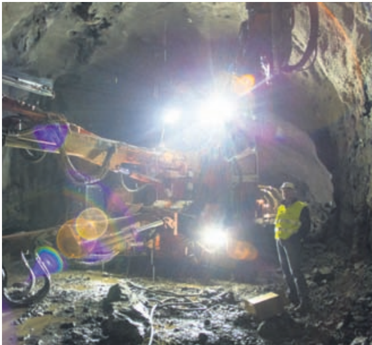
TIGNARLEGUR BOR Jón Leví Hilmarsson, verkefnisstjóri hjá ÍAV, sem stýrir vinnu við framkvæmdirnar, stendur hér við hliðina á bornum sem notaður er. Borinn er af gerðinni Tamrock.
