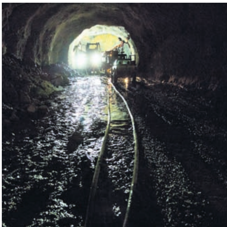
MIKILVÆGAR LEIÐSLUR Borinn sem notaður er við vinnuna er tengdur við rafmagns- og vatnsleiðslur sem liggja hér inn eftir göngunum.
