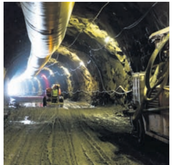
Á LEIÐ ÚT Starfsmaður Ósafis keyrir vinnulyftu út úr göngunum. Fyrir ofan má sjá loftræstirör sem nær inn öll göngin.
