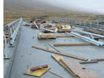
ÁIN BRÚUÐ Vinna við brúarsmíði yfir Norðfjarðará er langt komin. MYND/PORSTEINN VALUR
