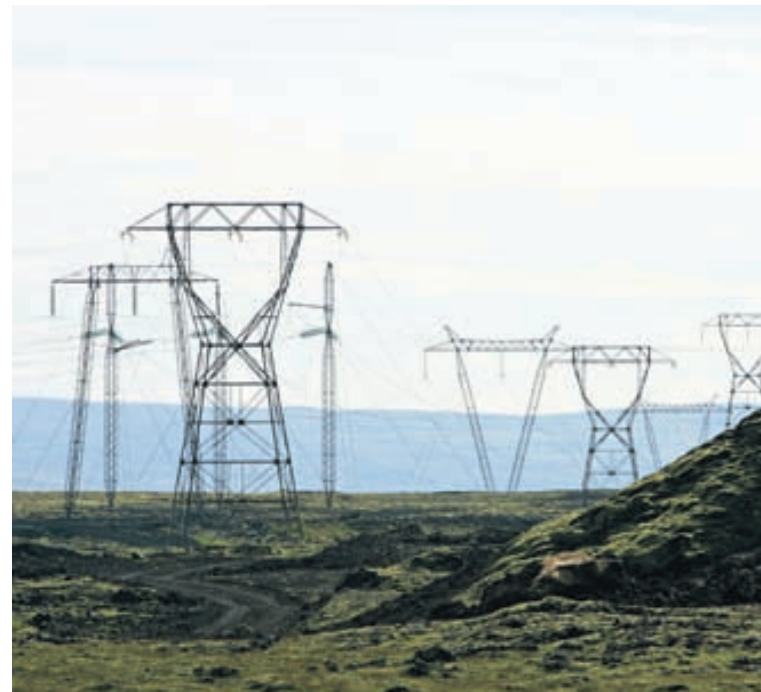
HÁSPENNUMÖSTUR Möstur sem þessi hér á Helliheiði þykja óvirda þrýði í landslagi og til nokkurs að vinna að fela háspennulínun eftir því sem kostur er.
