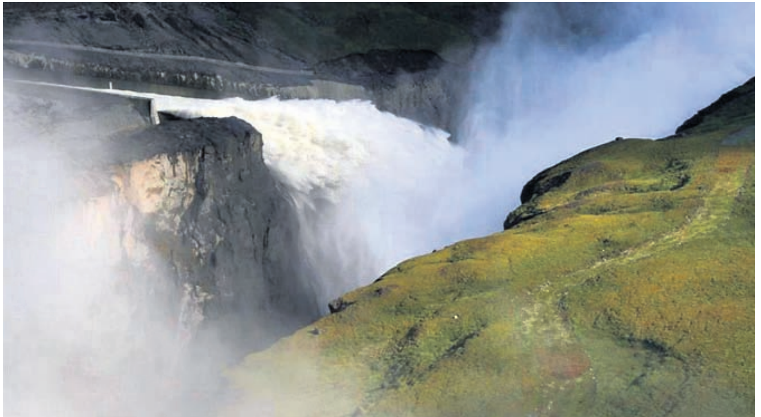
HVERFANDI Yfirfall Hálsóns er kannski eitt besta dæmið um hina ótryggu vatnsorku, sem er með of lítið afhendingaröryggi fyrir iðnað á Íslandi, og gæti hentað í sölu á sæstreng. Það gæti í meðalvatnsári numið 2 TWst eða 2/5 af því sem gæti farið á sæstrenginn. MYND/PÓRHALLUR ÁRNASON
