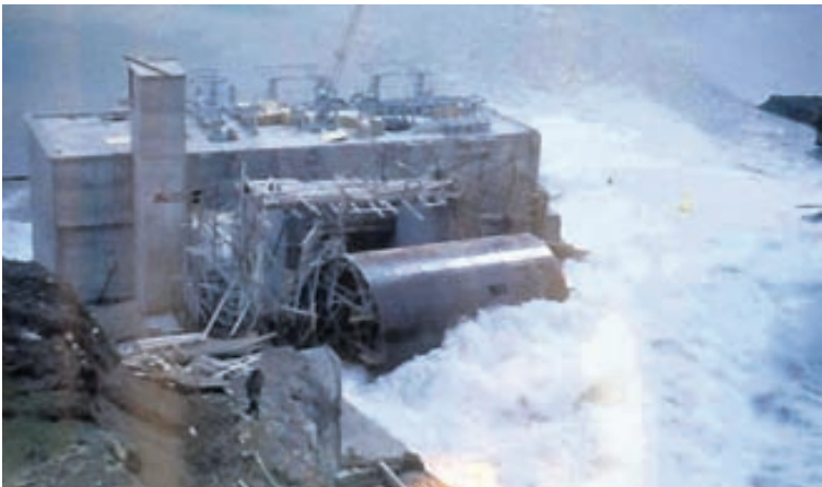
MÓTIÐ SKAUST ÚT Hér er horft niður að Úlfjótavatni, sennilega ofan við munn aðrennslisganganna. Sívalningurinn á miðri myndinni var notaður sem eins konar steypumót í göngunum og spýttist út með vatnsflaumum. Hann var sennilega um sex til sjö metrar á lengd.
