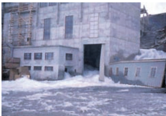
FLÆDDI UM ALLAR HÆÐIR Þrjár neðstu hæðirnar á stöðvarhúsinu fylltust af vatni þegar flaumurinn var sem harðastur.
