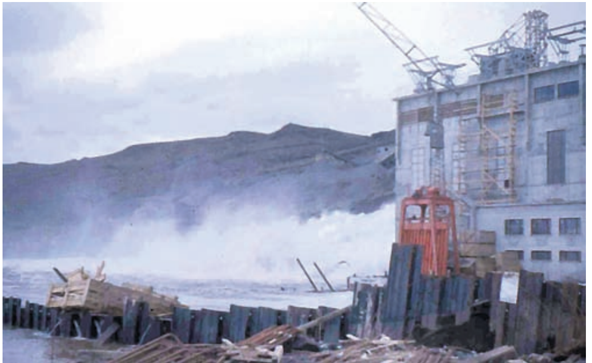
EYÐINGARKRAFTUR Hér sést gjörla hinn gríðarmikla kraftur sem var í flóðinu þar sem það streymir út um munn aðrennslisganganna og niður í Úlfjótavatn. Stöðvarhúsið er hér í forgrunni.
