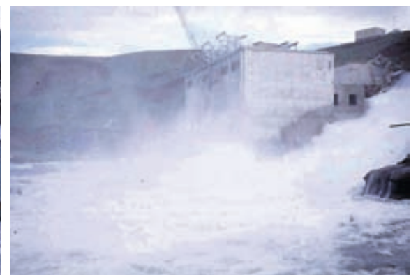
HVÍTFYSSANDI Vatnsflaumurinn umvafði stöðvarhúsið sem var langt komið í byggingu.
