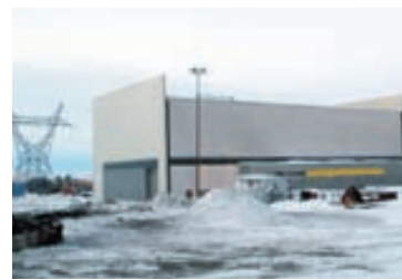
TENGIVIRKI Búðarhálslínu Orkuvirki setti upp háspennubúnað, en ístak byggði, lagði slóða og smíðaði undirstöður háspennumastra. MYND/LANDSNET
