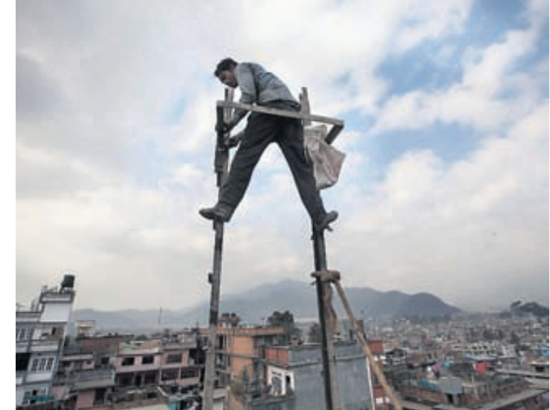
6 LAGAR LYFTU Í NEPAL Byggingaverkamaður vinnur þarna að því að lagfæra lyftubúnað á byggingarstað í Katmandú, höfuðborg Nepal. FRÉTTABLAÐIÐ/EPA
