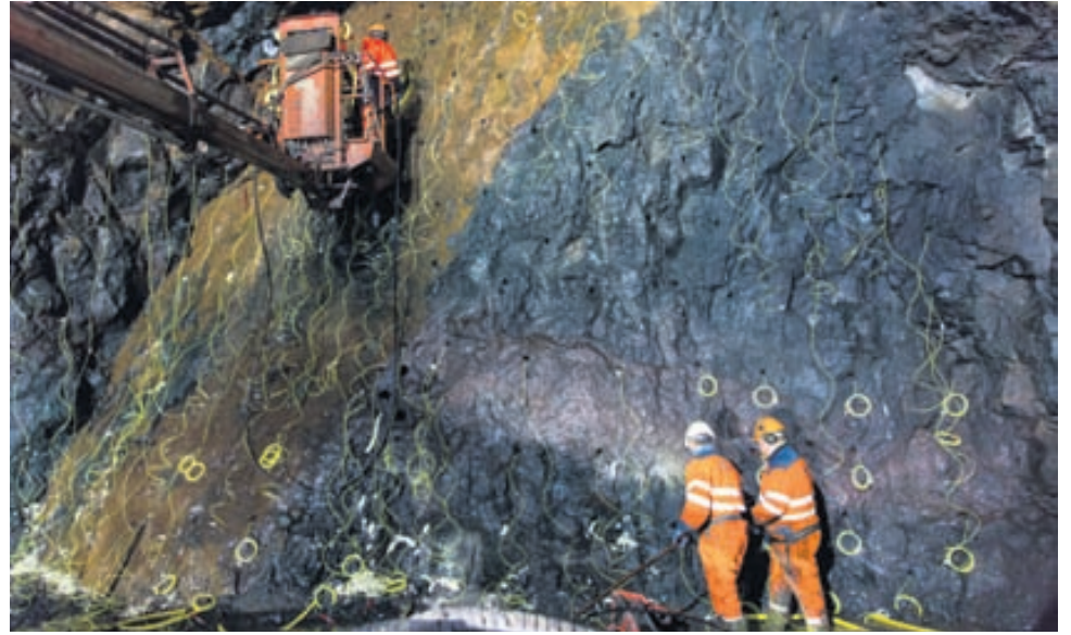
GÖNGIN LENGJAST Framkvæmdir við Vaðlaheiðargöng eru á áætlun en byrjað var að sprengja fyrir þeim í júní. Um 40 manns vinna við göngin Eyjafjarðarmegin á vöktum allan sólarhringinn og eru göngin nú orðin tæplega 1,5 km að lengd.
