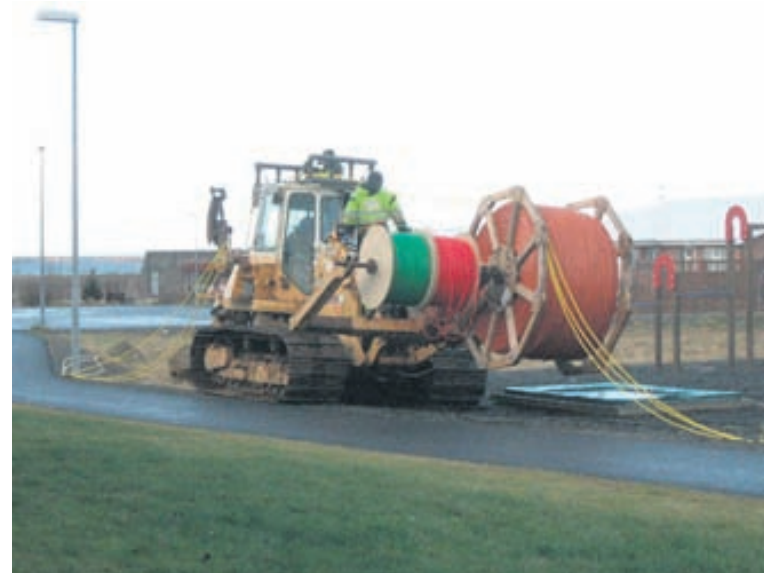
FER Í ÖLL ÍBÚÐARHÚS Starfsmenn Þjótanda sjá um lagningu ljósleiðarans.
