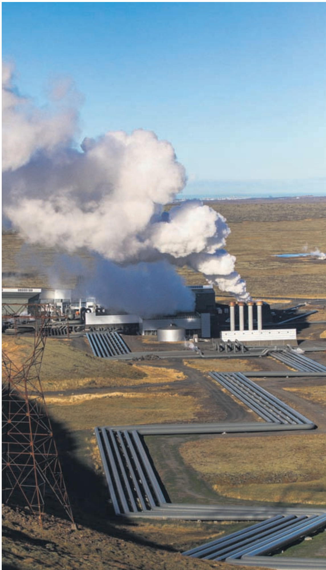
Á HELLISHEIÐI Jarðvarmi úr um fimmtíu borholum er nýttur til framleiðslu á rafmagni í Hellisheiðarvirkjun.
