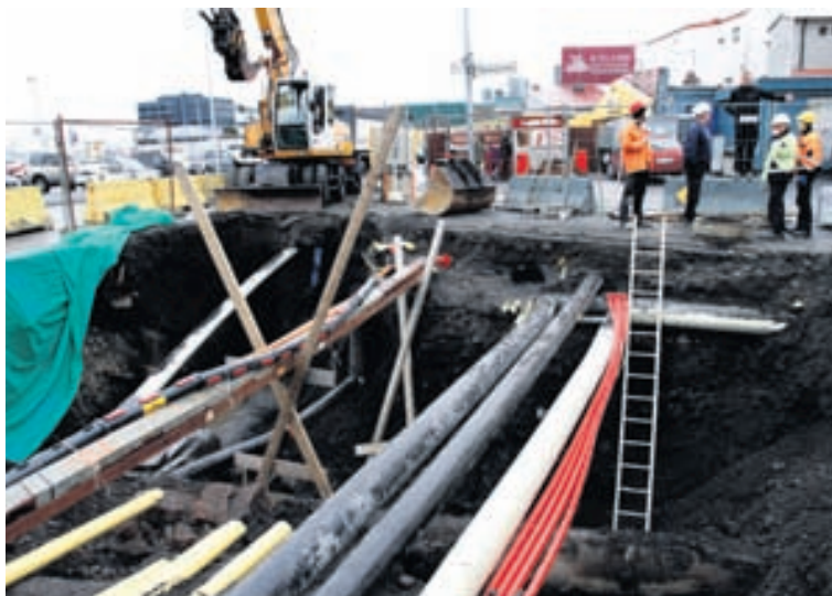
FRAMKVÆMDIR Ný gata við Pósthússtræti verður samkvæmt áætlunum tilbúin í júlí 2015. FRÉTTABLAÐIÐ/GVA
