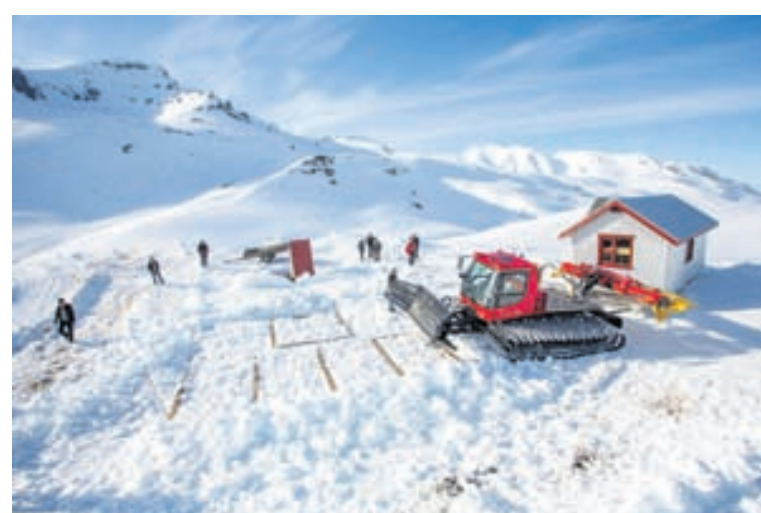
MOKAÐ Mikill snjór er enn á Glerárdal og þurfti að moka niður á undirstöðurnar. MYND/VÖLUNDUR
