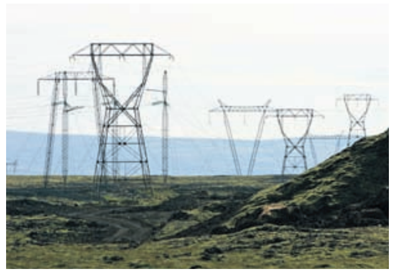
UNNIÐ VIÐ RAFLÍNUR Raforka hefur verið skert í fjörgang frá áramótum. Afkastageta byggðalínunnar er ekki nægjanleg. FRÉTTABLAÐIÐ/VILHELM
