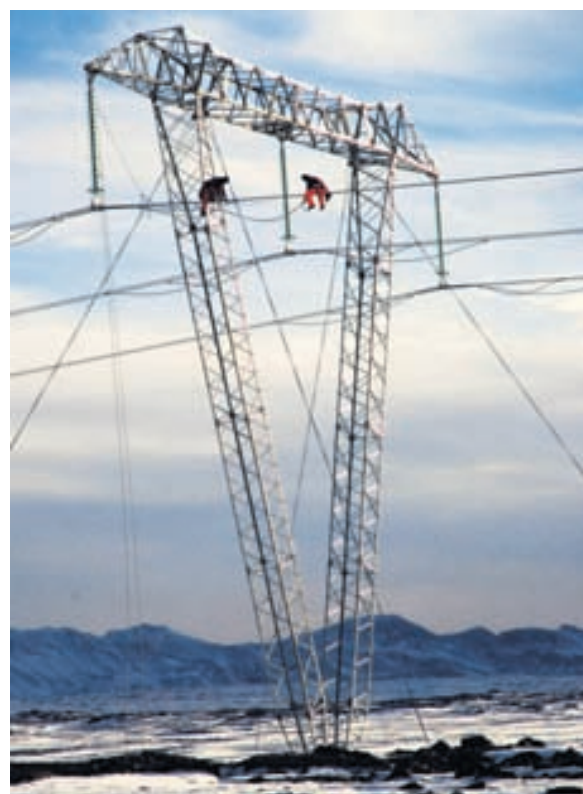
BYGGÐALÍNA Raforkuflutningar til Eyjafjarðar eru í molum og úrbóta er þörf.
