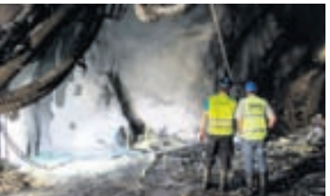
RÖR Starfsmenn lögðu rör í vegginn fyrir vatnið. MYND/VHG
