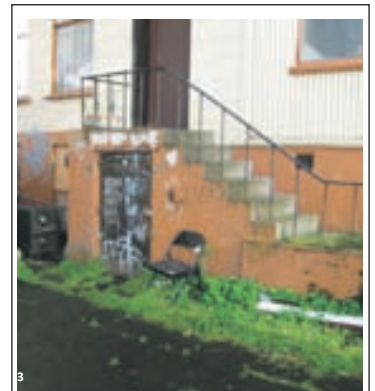
Laugavegur 33 Kjallari hússins er yfirgefinn og lokaður en búið er á efri hæð þess.
