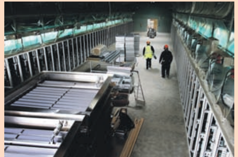
FRAMKVÆMDIRNAR Gagnaverið er reist á Fitjum í Reykjanesbæ en byggingu þess lauk í maí. FRÉTTABLAÐIÐ/GVA
