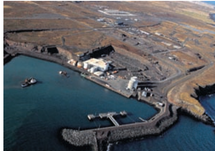
HELGUVÍK Framkvæmdir á lóð United Silicon eru hafnar og Thorsil stefnir einnig að byggingu kísilmálmverksmiðju á svæðinu.
