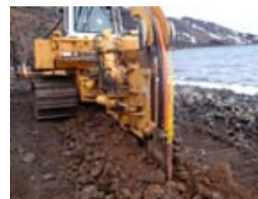
Unnið að lagningu háspennustrengs og ljósleiðara við Kleifarvatn. Farið er fyrir enda á sandklöppum þar sem grafan er ofan í vatninu.
