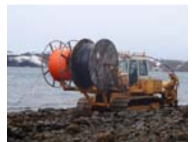
Unnið að lagningu háspennustrengs og ljósleiðara við Kleifarvatn. Farið er fyrir enda á sandklöppum þar sem grafan er ofan í vatninu.
