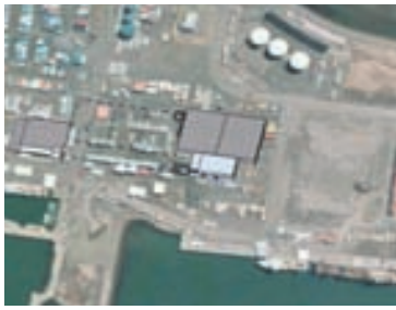
FRAMKVÆMDIR Athafnasvæði Eimskipa við Hafnarfjarðarhöfn. MYND/EIMSKIP
