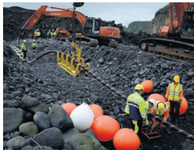
STRENGUR LAGÐUR Frá landtöku nýs sæstrengs, sem þá varð jarðstrengur, í Vestmannaeyjum í fyrrahaust. MYND/LANDSNET
