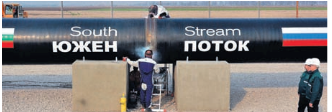
HÆTTU VIÐ FRAMKVÆMDIR Framkvæmdir við lagningu gasleiðslunnar voru kynntar með táknrænni viðhöfn fyrir rúmu ári.
