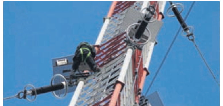
Í MASTRINU Ekki er hlapið að því að gera við öryggisljós sem vara eiga flugmenn við hinu 220 metra háa langbylgjumastri á Eiðum.
