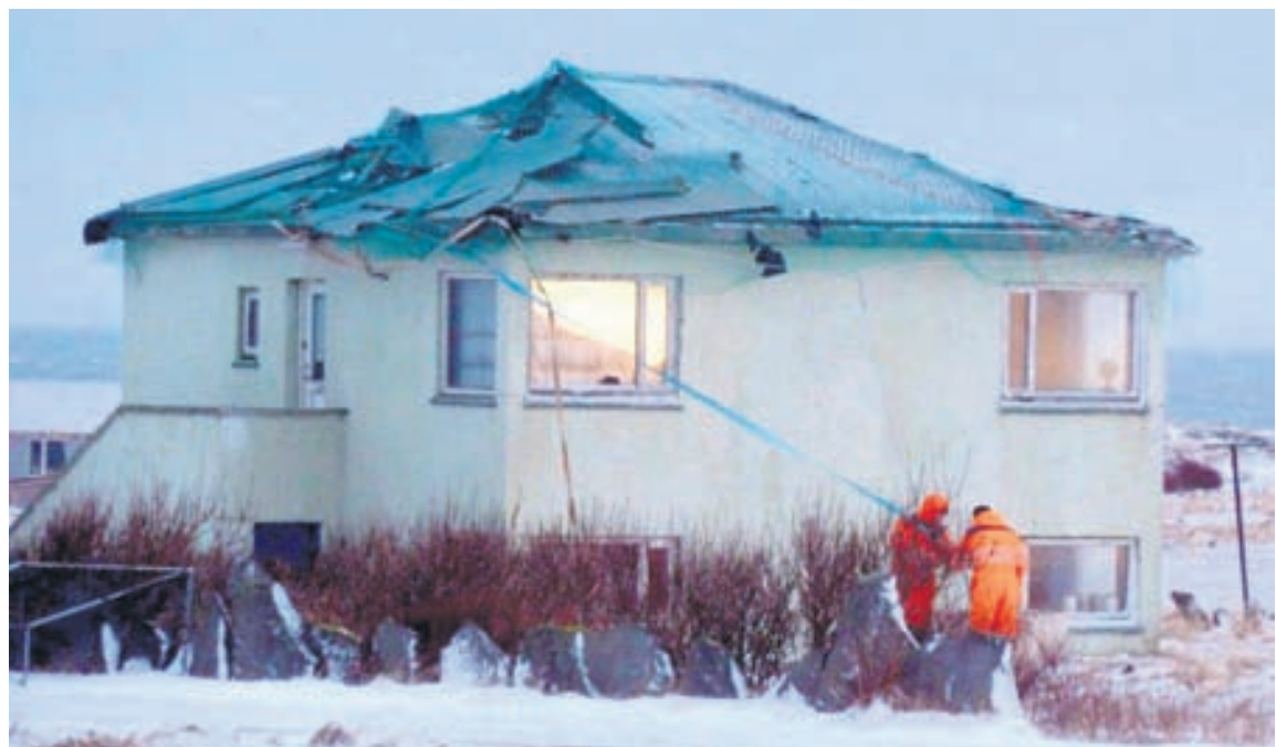
FISKINET YFIR PAKINU Íbúðarhúsið Vík í Garðinum er stórhættulegt að mati björgunarsveitarmanna. Þar er fiskinet notað til að halda lausum þakplötum í skefjum þegar vindar blása um Garðinn. „Ef netið rifnar og allt fer af stað þá eru íbúarnir þarna í kring náttúrulega í hættu,“ segir Oddur Jónsson, formaður björgunarsveitarinnar Ægis í Garði, um húsið.
